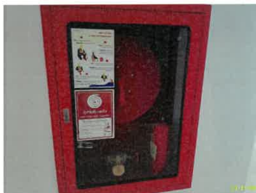
ตู้สายน้ดับเพลิง และป้ายบอกวิธีการใช้อุปกรณ์ ภาพที่ 1.3.9-1 ระบบแจ้งเตือน และป้องกันอัคคีภัย
